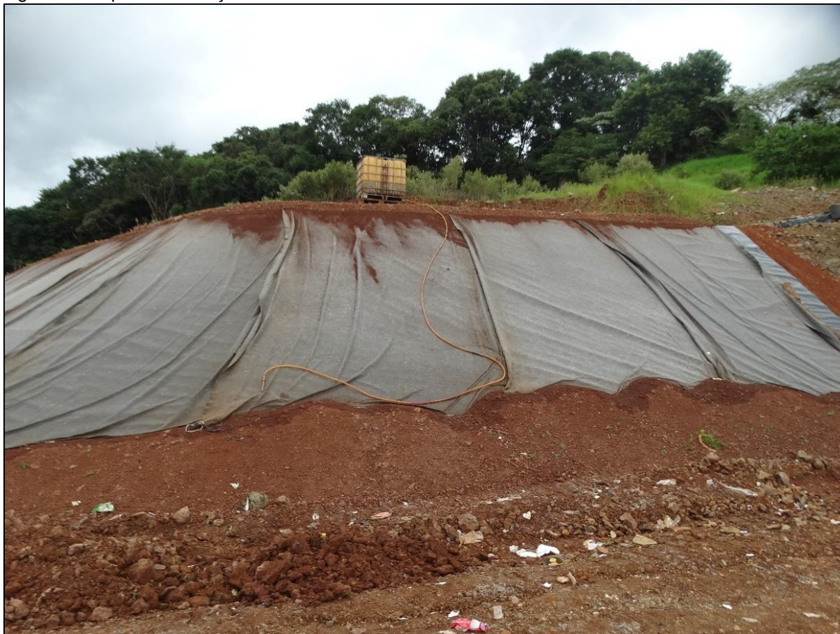
Figura 20: Impermeabilização da célula encerrada com PEBD.
