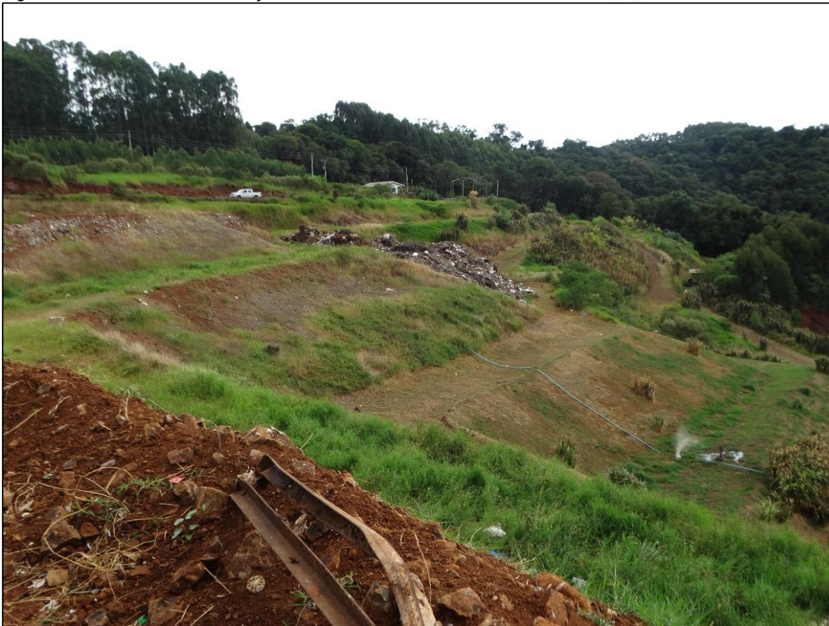
Figura 28: Sistema de recirculação de efluentes no aterro.
