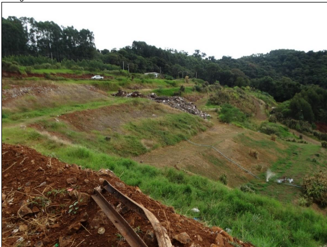
Figura 18: Cobertura das células encerradas com gramíneas e vegetação nativa e exótica formando a cortina vegetal.
