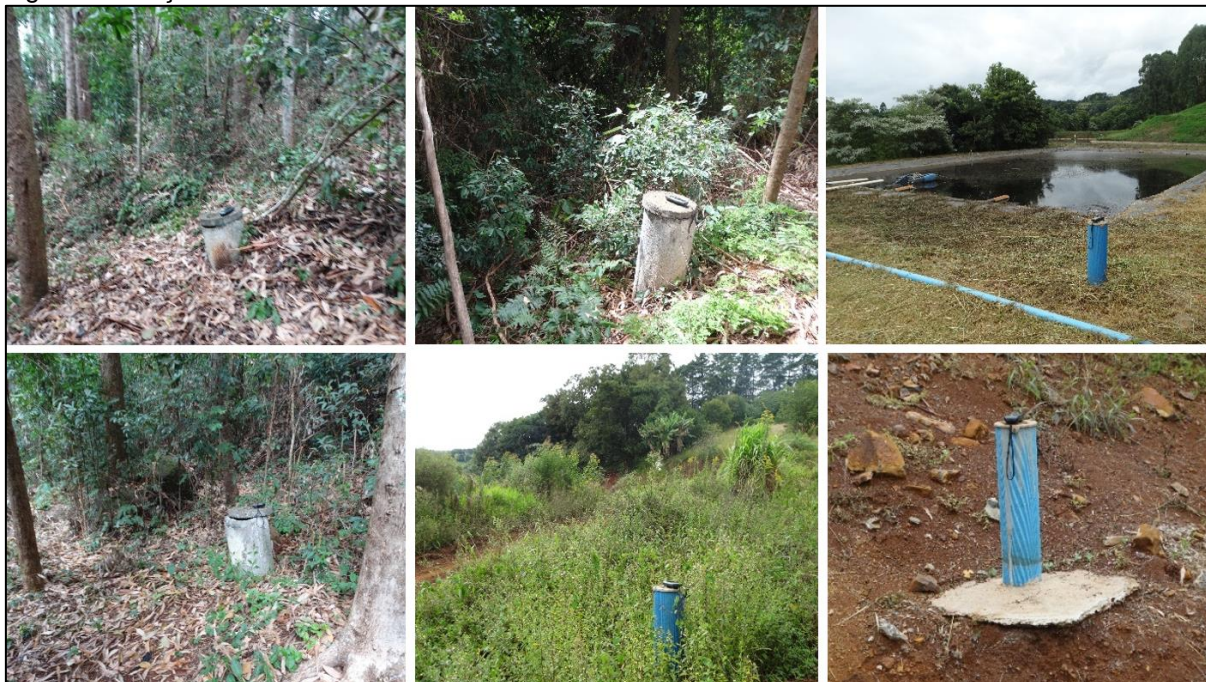
Figura 29: Poços de monitoramento instalados na área do aterro.
